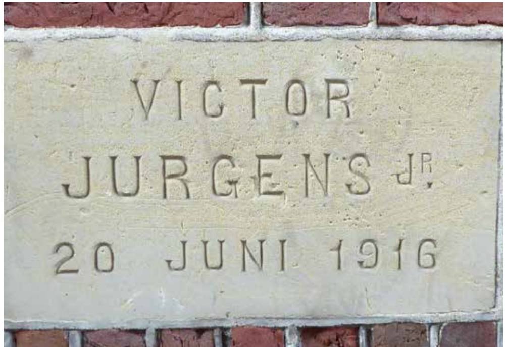
De gedenksteen in de onderdoorgang van het stalgebouw
