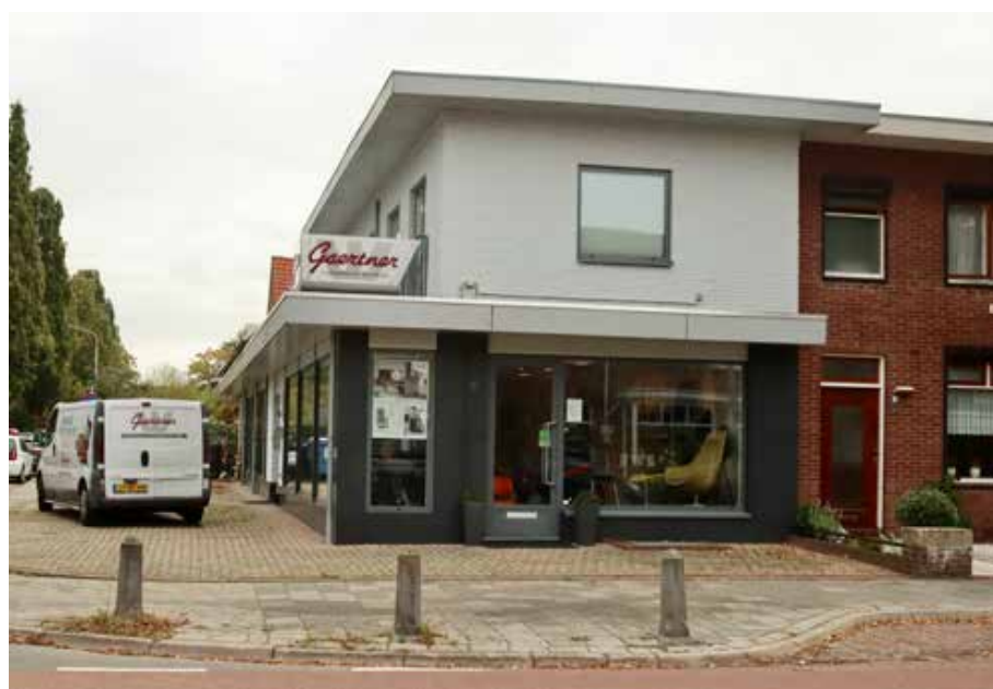
Het opvallende pand aan de Heyendaalseweg.
